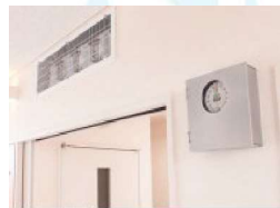
HCU個室に設置された 陰圧装置
