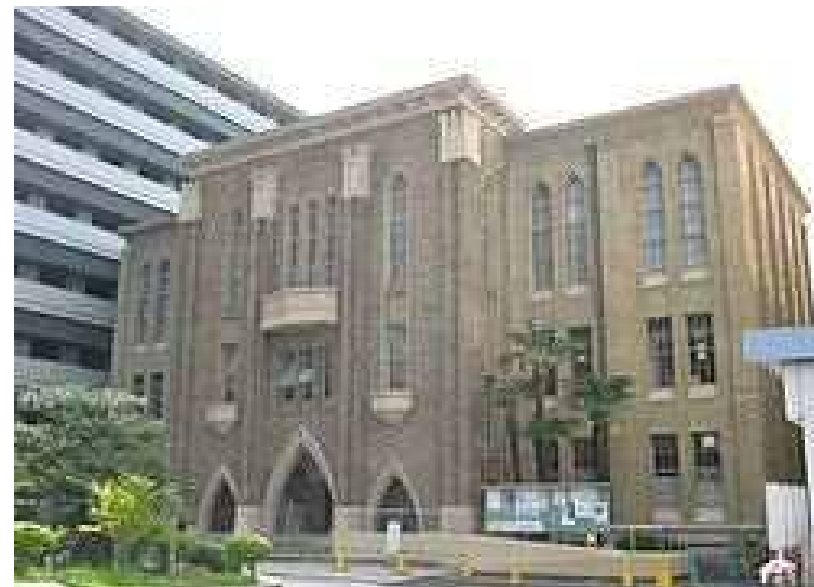
京都府立医科大学・旧附属図書館（京都市上京区）
