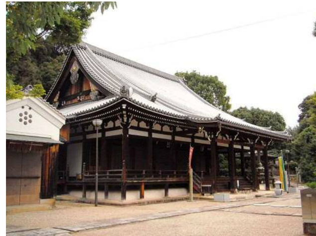
宝塔寺(京都市伏見区深草宝塔寺山町)
